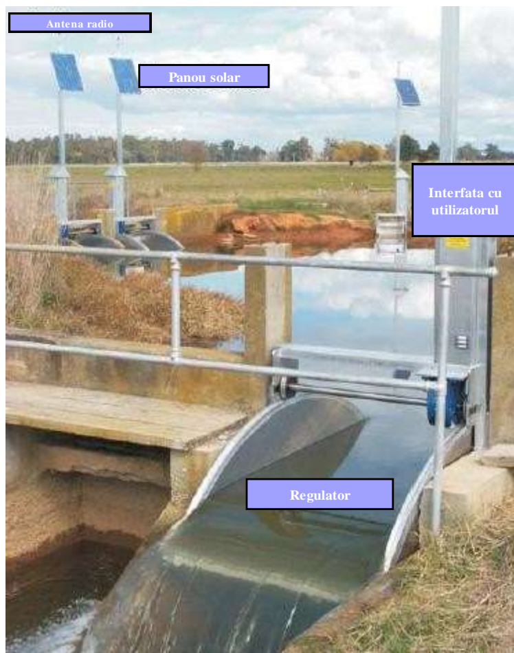
Fig 6. Structura sistemului Rubicon Systems Australia
