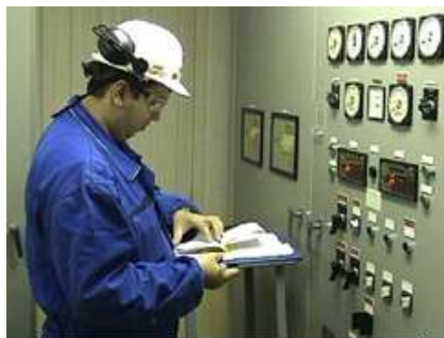
Efectuarea rutinelor si verificarilor in instalatie de catre operatorii nucleari
