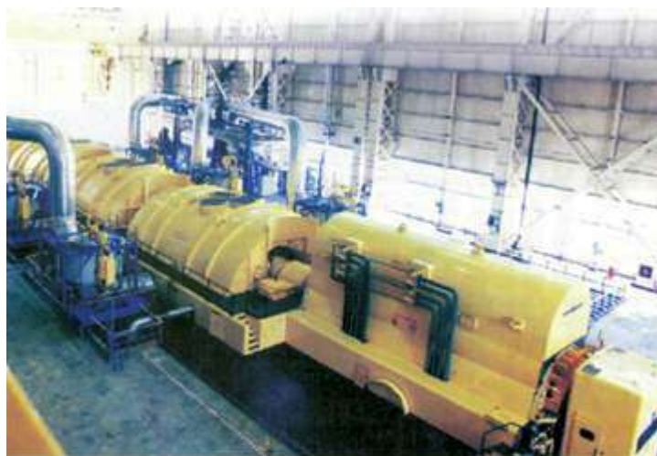
Vedere de ansamblu Turbina-Generator
